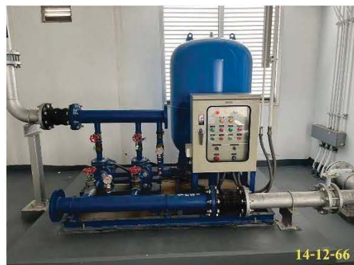
ถังเก็บน้ำชั้นดาดฟ้า และเครื่องปั้มน้ำ อาคาร C
