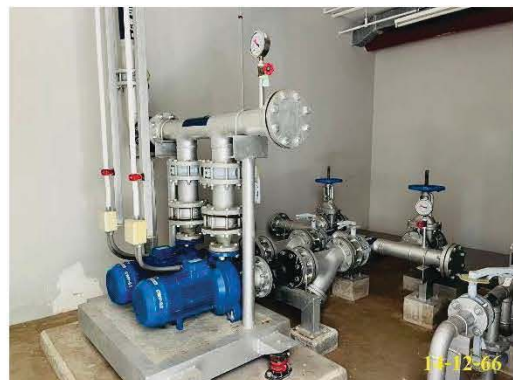
ถังเก็บน้ำใต้ดิน และเครื่องปั้มน้ำ อาคาร B
