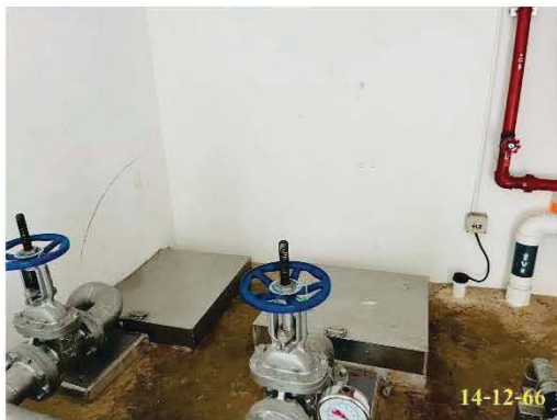
ถังเก็บน้ำใต้ดิน และเครื่องปั้มน้ำ อาคาร C
