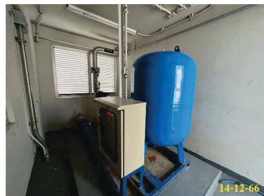
ถังเก็บน้ำชั้นดาดฟ้า และเครื่องปั้มน้ำ อาคาร E
